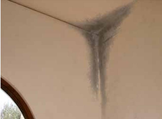
Las variaciones térmicas generan tensiones en la superficie exterior de las estructuras, a causa de la diferente dilatación térmica que caracteriza los distintos materiales que las componen. Por consiguiente, es muy probable que en una fachada se puedan formar fisuras y grietas más o menos evidentes, que favorezcan las infiltraciones de agua y por lo tanto los fenómenos de disgregación y ruptura de los acabados y de los enlucidos.
