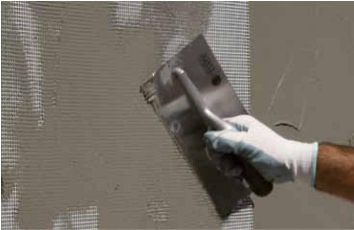
Una vez terminada la ejecución de la capa de enrasado, la malla debe quedar entre la mitad y el primer tercio exterior de toda la capa. Las zonas que estén más expuestas a impactos (p.ej. las zonas de paso hasta 2 m de altura) pueden armarse con una doble capa de malla. En este caso la segunda capa se extiende horizontalmente.
