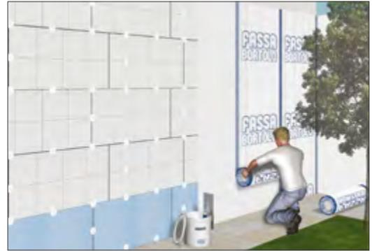
El solapado de la malla, en sentido horizontal y vertical, debe ser al menos de 10 cm y 15 cm cerca de los bordes, previamente protegidos con ángulos de PVC, reforzando las esquinas para las aperturas de las ventanas con secciones oblicuas con paños de malla aproximadamente de 35 x 20 cm.
