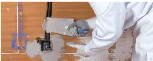
**3** Iberplast se utiliza para la sujeción de instalaciones y elementos auxiliares.
